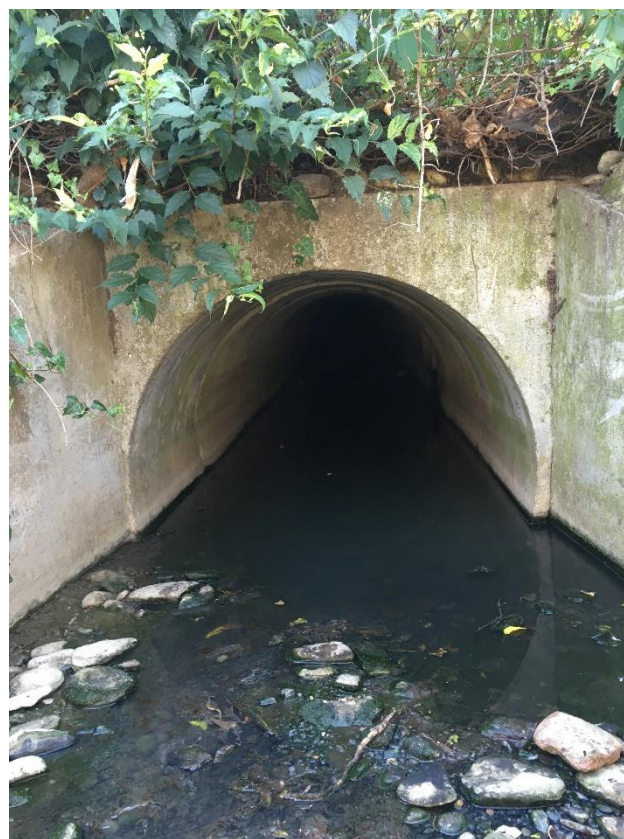
FIGURA 3: RIO DELLE VALLI, SBocco DEL CONDOTTO A MONTE DELLA FFSS
