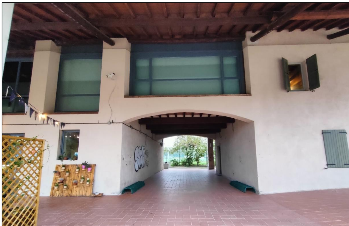
Particolare fronte Ovest, con vista della porta morta oggetto di intervento.
